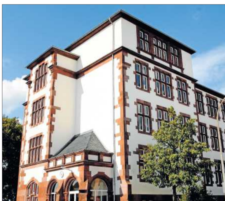
Die Grundschule auf dem Horeb: Sie soll generalsaniert und zu einer Schwerpunktschule für Inklusion werden. (Foto: Archiv/PZ)
